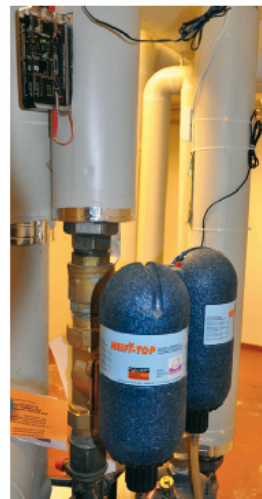
Kuvassa Vulcan -vedenkäsittelylaite ja alakuvassa sakan ja ilmanerotin lämmitys- ja jäähdytysjärjestelmiin.
