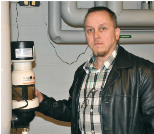
Kuvassa Vulcan -vedenkäsittelylaite ja alakuvassa sakan ja ilmanerotin lämmitys- ja jäähdytysjärjestelmiin.
